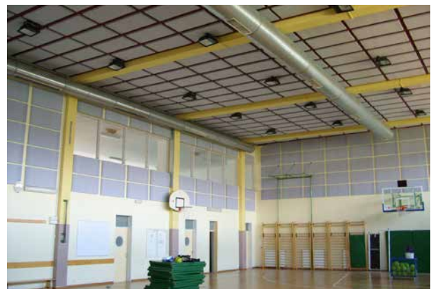
Decke, Wände mit Akustikpaneelen
