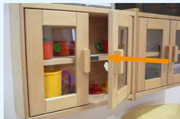
Filzstreifen, Anschlagdämpfer an Türen, Kistentüren, Holzladen, ... verringern Lärm.
